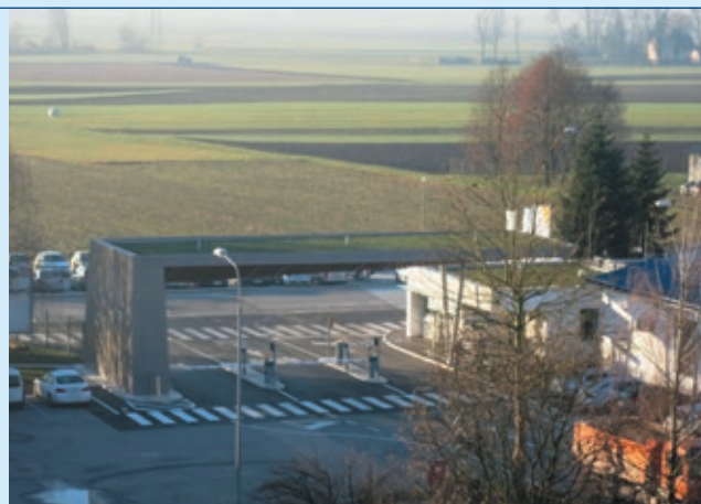
Zelena streha na prenovljenem glavnem vhodu na lokaciji Mengeš
